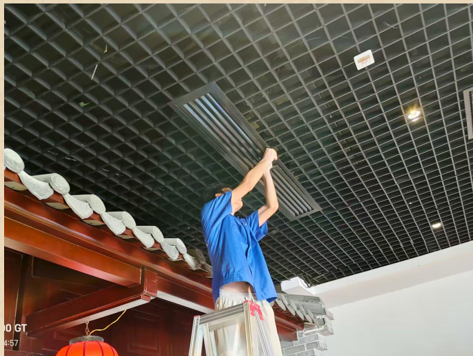
展厅空调维修
