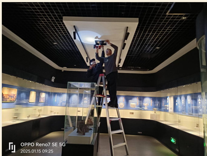
展厅灯具维修
